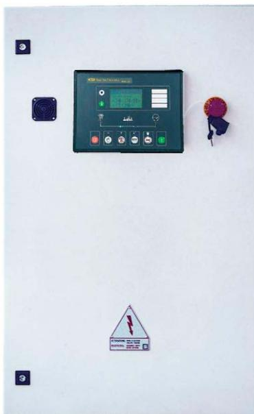
**QUADRO ELETTRICO COMPLETO DI COMMUTAZIONE, FORNITO IN ARMADIO SEPARATO**
