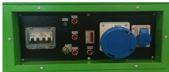
1 Presa CEE 230 V monofase 3 poli 32A, 1 Presa CEE 230 V monofase 3 poli 16A, Interruttore magnetotermico di protezione, voltmetro a led, fusibile di protezione e chiave avviamento con spie.
