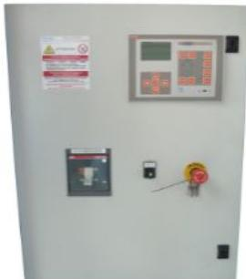
Centralina RGK800 SA con multmetro (voltmetro, amperometro, frequenzimetro, contaore e voltmetro batteria).
