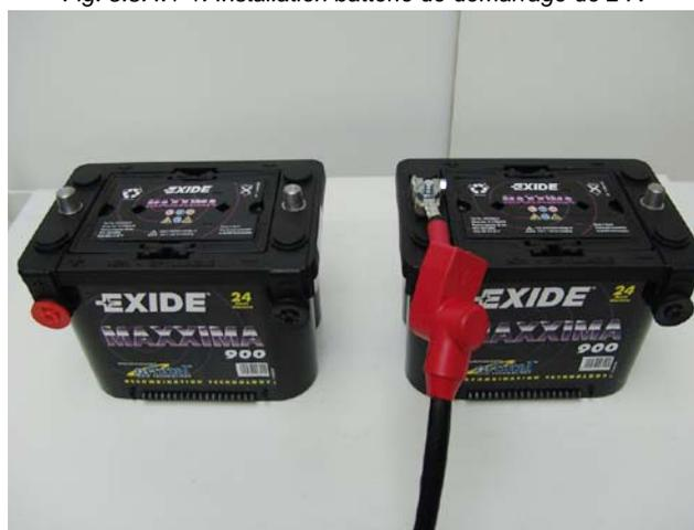
2. raccorder le câble (-) au pôle (-) de la deuxième batterie.
