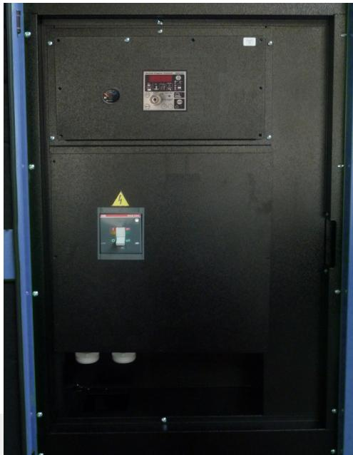
**Centralina BE24 con multmetro (voltmetro, amperometro, frequenzimetro, contaore e voltmetro batteria)**
