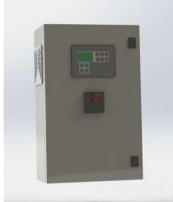
QE con centralina elettronica di comando e controllo Alternatore e Motore. Previsto il controllo interno presenza rete. In modalità AUTO alla mancanza rete, effettua l'avviamento del GE e automaticamente comanda lo scambio rete/gruppo. In alternativa può essere avviato da contatto remoto o in modalità MAN. Provvisto di selettore a chiave per attivazione logica, cicalina tacitabile, caricabatteria automatico, ed interruttore magnetotermico con manovra in
