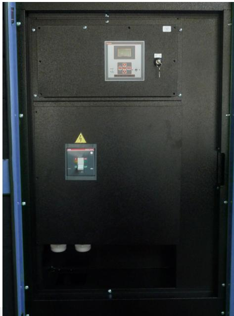
**Centralina RGK600 SA con multimeter (voltmetro, amperometro frequenzimetro, contaore e voltmetro batteria).**
