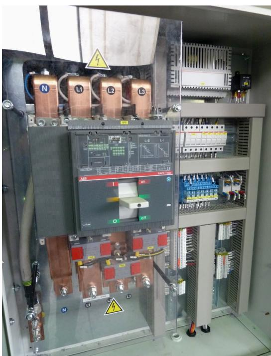
**Centralina RGK800 con multimetro (voltmetro, amperometro frequenzimetro, contaore e voltmetro batteria). Caricabatteria, funzione test periodico e riferimenti di rete. Moduli di espansione EXP ed ingresso analogico programmabile.**
